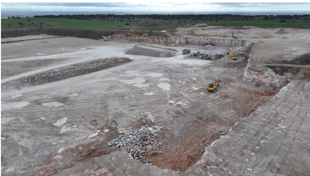
Vista general del frente de arranque y detalle de los equipos de trituración y clasificado.
